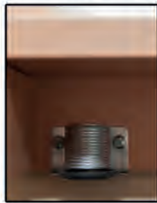
Abbildung rechts: Sockelhöhenversteller verdeckt in Sockel montiert
