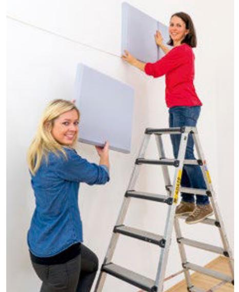
3. Bringen Sie die Schallabsorberplatte an der von Ihnen vorgesehenen Stelle (Decke oder Wand) an. Um die Platten gerade anzubringen, kann eine Schnur zur Hilfe genommen werden. Noch einige Minuten nach Anbringen der Platten ist eine Korrektur der Linienführung bei Bedarf möglich.
